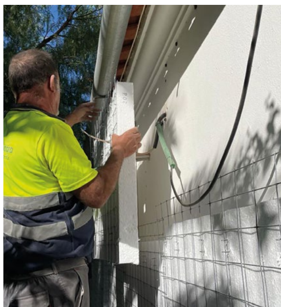
SATE exterior en vivienda, Ronda, Málaga
