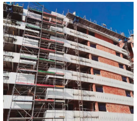
Cerramiento y petos en edificios de viviendas en Hacienda Cabello, Málaga
